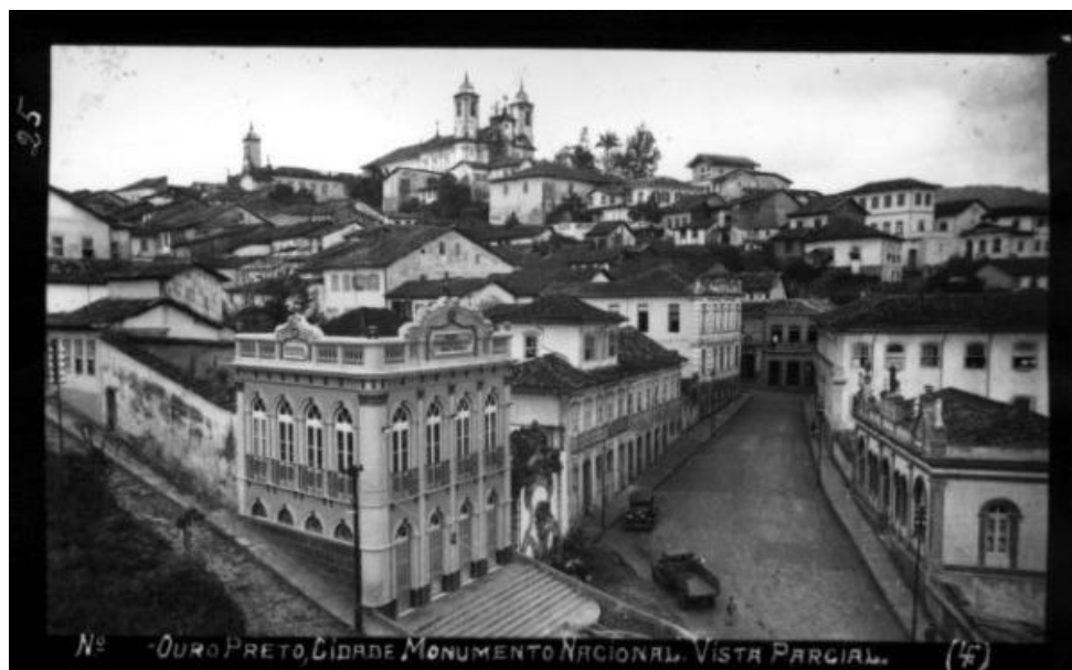
OURO PRETO, CIDADE MONUMENTO NACIONAL, VISTA PARCIAL.
