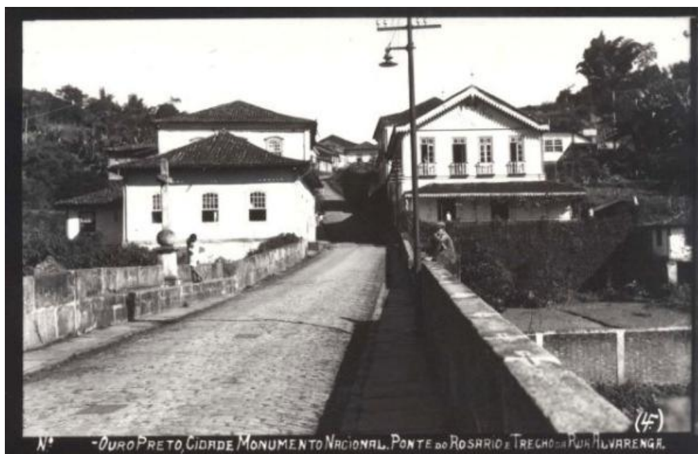
OURO PRETO, CIDADE MONUMENTO NACIONAL. PONTE DO ROSÁRIO E TRECHO DA RUA ALVARENGA.
