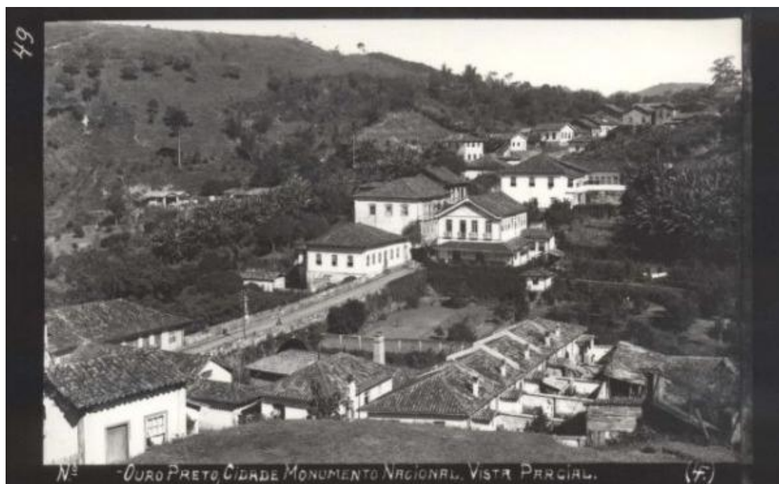
OURO PRETO, CIDADE MONUMENTO NACIONAL, VISTA PARCIAL.
