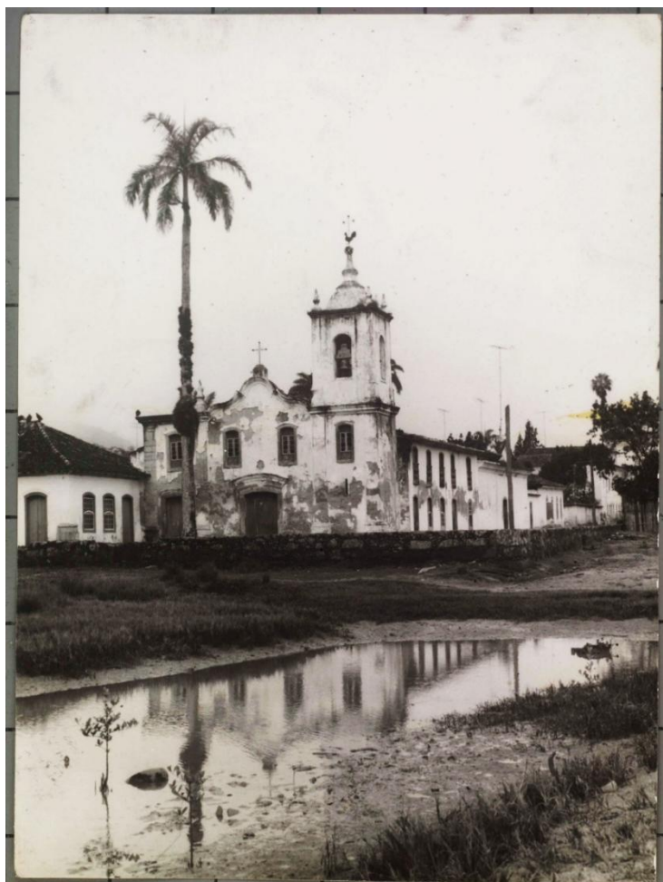
IGREJA DE NOSSA SENHORA DAS DORES (CAPELINHA) – CENTRO HISTÓRICO DE PARATY. EDIFICADA EM 1800.
